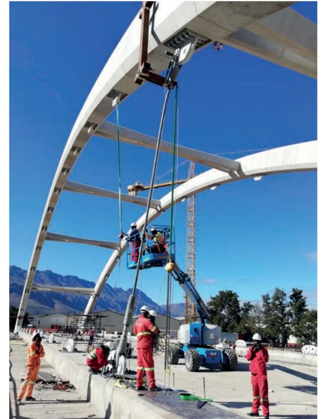
cando os apoios num pilar antes de repetir o processo nos doze pilares seguintes; para elevar e baixar o tabuleiro por pilar, foram usados macacos hidráulicos de 500 toneladas.
